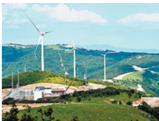
● 龍源為國家能源投資集團的子公司，主要經營風電、光伏、生物質、火電等發電項目。圖為集團旗下風電場項目。資料圖片
