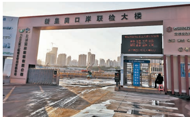
◆新口岸聯檢大樓施工工地。 香港文匯報記者石華攝
