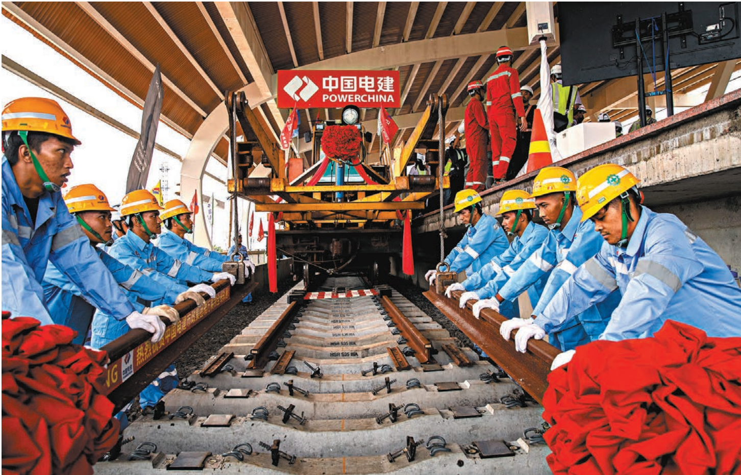
◆3月31日，在印度尼西亞雅加達雅萬高鐵哈利姆車站，工人鋪設雅萬高鐵全線最後一根鋼軌。
