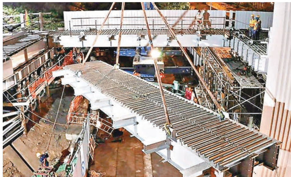
工程團隊應用新技術協助興建臨時行車天橋，提升工程效率。
