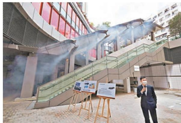
外形像飛機翼的送風裝置。
