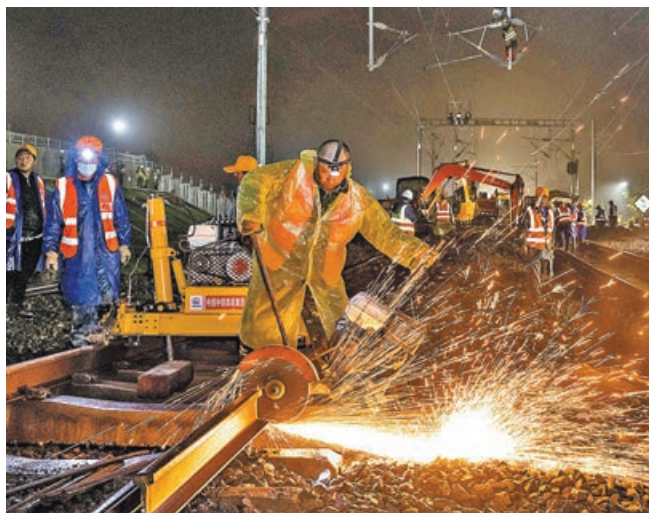
■ 27日凌晨，工人正緊張施工，趕及在7小時內把滬蓉高鐵成功「搬家」。
