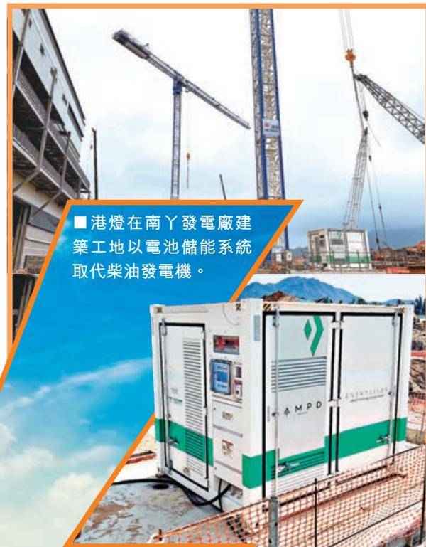
港燈在南丫發電廠建築工地以電池儲能系統取代柴油發電機。
