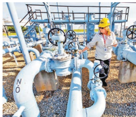
一名「殖民管道」員工在檢查輸油管道。網上圖片
