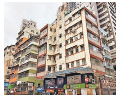
■大角咀橡樹街埃華街項目涉及兩幢舊樓。
