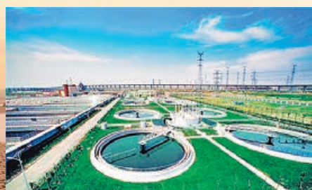
■光大污水處理設施。
