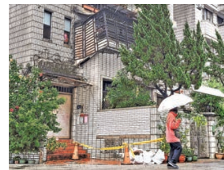
■台北有民宅發生屋簷掉落、外牆剝落狀況。 中央社
