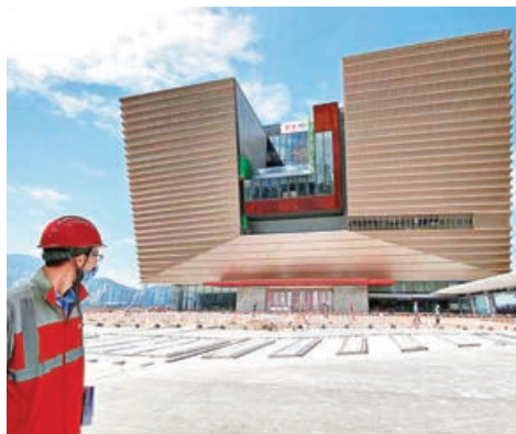
■正在建築中的香港故宮文化博物館。
