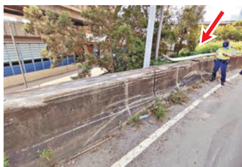
田螺車失控前疑掃毀一段欄杆(箭嘴示)。
