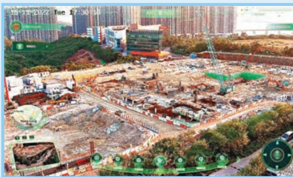
將軍澳中醫醫院地盤採用「智慧工地」系統監控。
