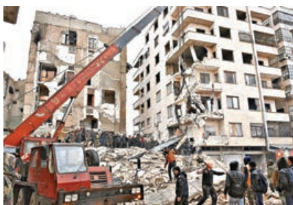
■6日，在敘利亞哈馬省，人們在一處倒塌的建築現場進行救援。
