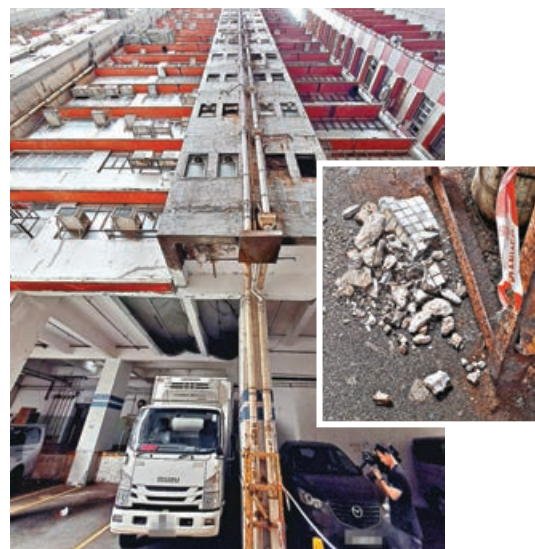
■由大廈高處墜下的石屎擊中一輛貨車車頂，小圖為石屎部分連「紙皮石」散落一地。
