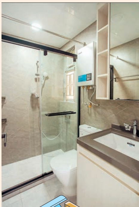
■淋浴間設有玻璃趟門。
