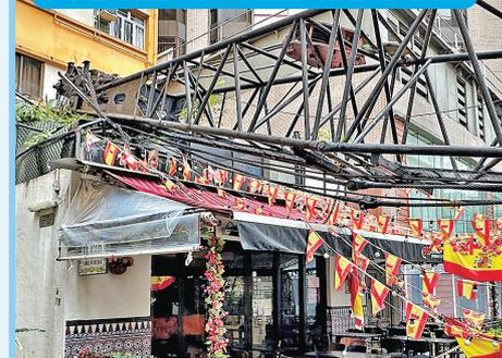
昨日上午紅雨生效期間，尖沙咀金巴利道49至51號商廈重建地盤一部26米長起重機吊臂，疑因天雨致泥土鬆散，失去平衡向前塌下，壓毀諾士佛臺的酒吧簷篷及平台花園，當時有十多名工人正在進行地基工程，幸無人受傷。警方隨即圍封現場，將案件列作高空墮物處理。
