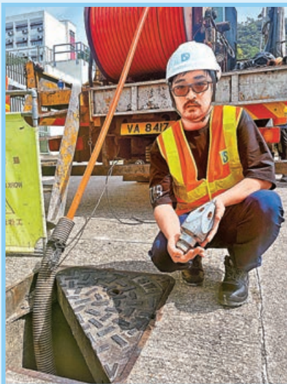
渠務署人員手上的加壓水噴頭，能夠將淤塞物打散及沖走。
