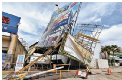
■台中市一處鐵皮屋疑不堪強風吹襲而傾倒。中央社
