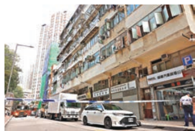
■唐樓出現裂縫，警方封鎖整條永康街。
