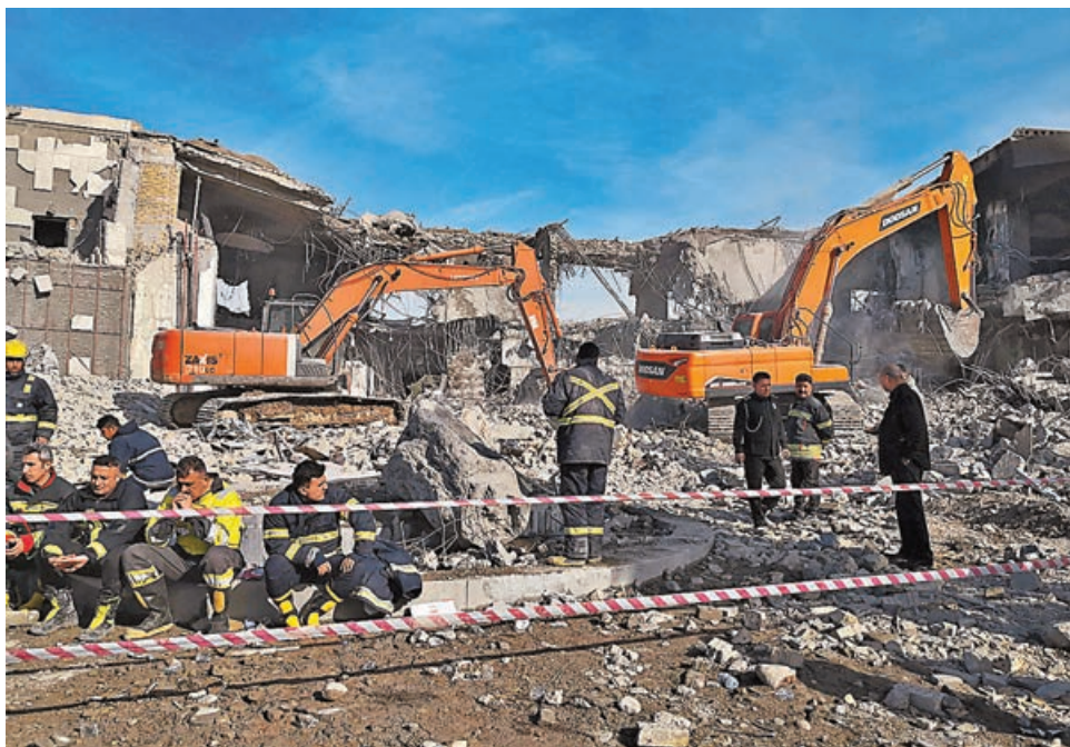
■伊拉克救援人員清理被伊朗空襲倒塌的房屋。
