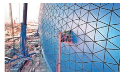
■主場館表面由約2.7萬塊不同形狀的三角形鋁質面板組成。
