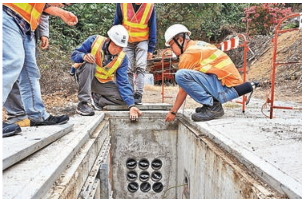
■工程人員正為鄉村進行光纖網絡鋪設工程。
