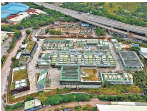
新圍污水廠改善工程出現滲漏。
