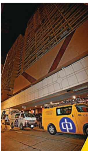
中電派工程人員搶修。
