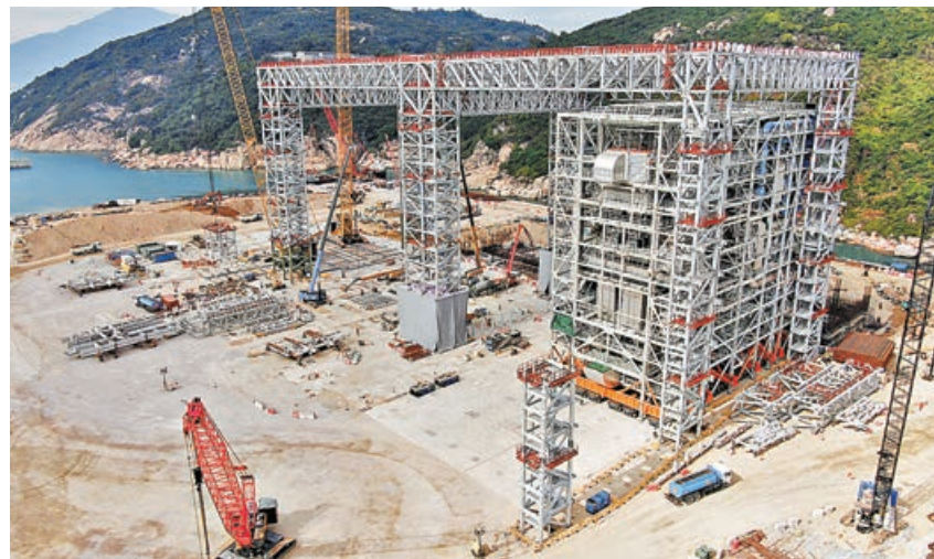
■興建中的綜合廢物管理設施第一期。
