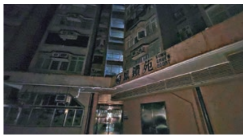
■鑽石山鳳鑽苑有大廈全幢停電一片漆黑。
