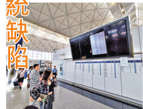
■ 機場航班顯示系統一度故障。
