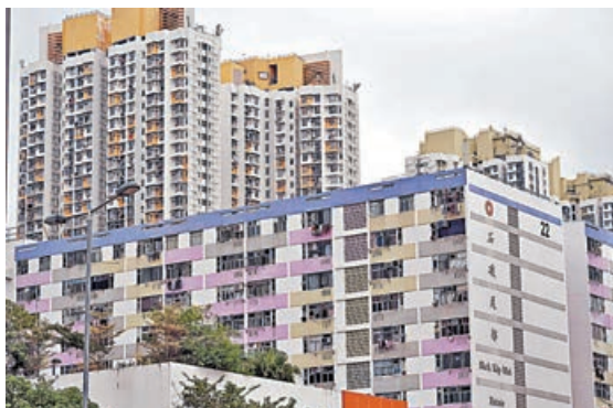
■深水埗石硤尾一帶前晚發生電壓驟降事故。
