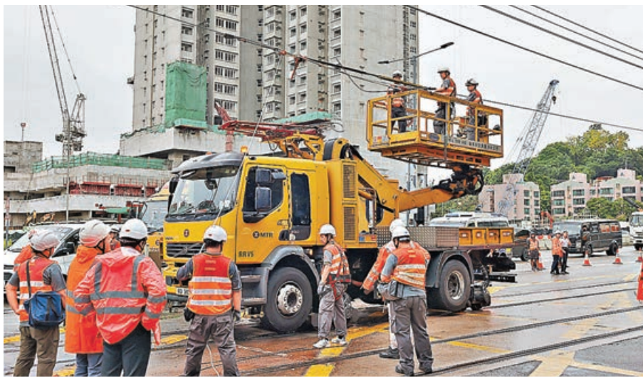
港鐵工作人員在場搶修及檢查電纜。
