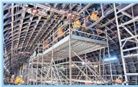
港鐵更換承載電纜的金屬吊架及其他隧道設備。
