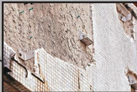
■大廈外牆多處有紙皮石脫落。
