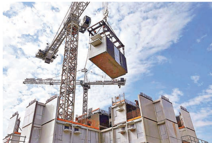
■ 工地安全需要引起重視，圖為使用組裝合成建築法的工地。
