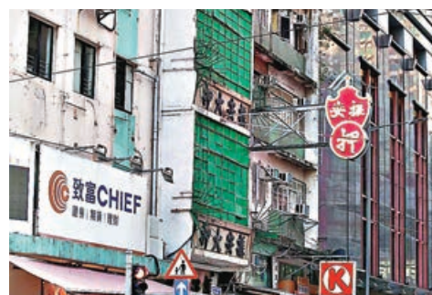
■原有綠色鐵窗框於2021年拆除。
