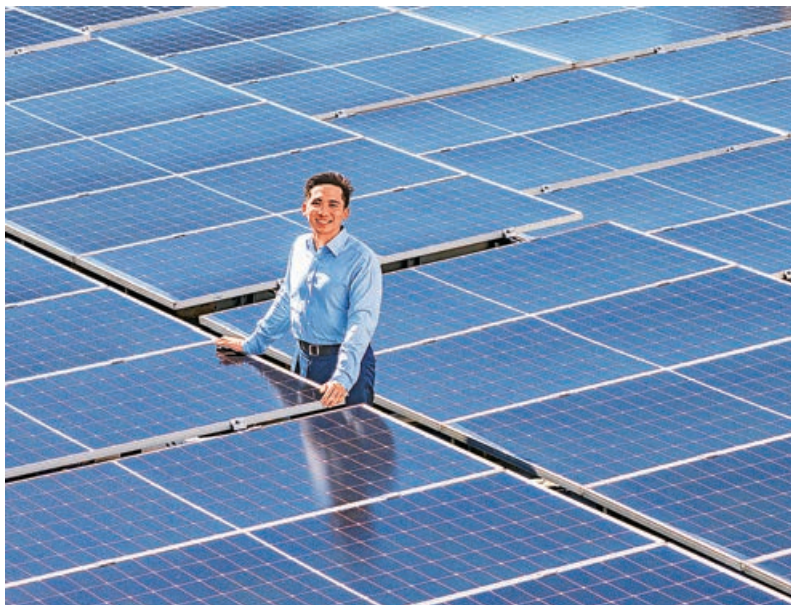
■郭基泓表示，明年底前旗下太陽能發電系統將共提供逾2萬塊太陽能板。
