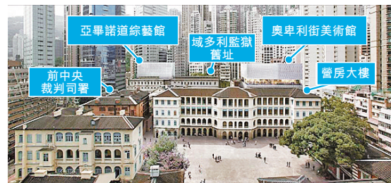
■建築群內有多幢歷史建築物。
