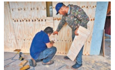
佛州坦帕市工人為窗戶釘上木板，嚴防颶風「米爾頓」來襲。
