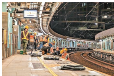
■大學站月台正安裝LED燈帶鋼板。
