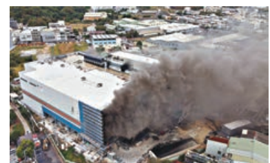
■倉儲工地建築被濃煙吞沒。
