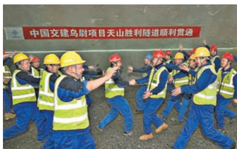
■施工人員慶祝隧道貫通。 新華社
