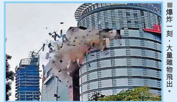
意外樓層事後仍冒煙，窗戶盡毀。香港中通社
