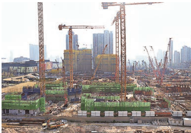
啟德世運道簡約公屋地盤正在施工。
