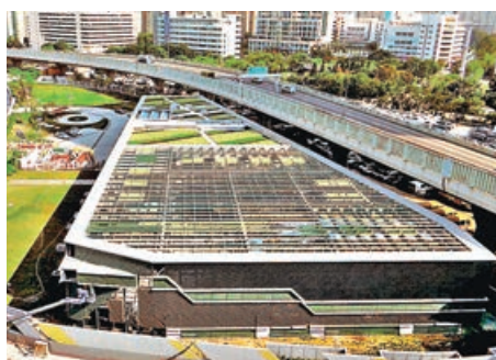
啟德發展區區域供冷系統(北廠)。
