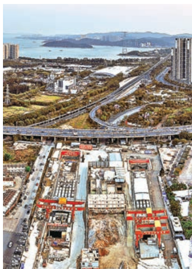
■汕頭高鐵路海底隧道施工現場。
