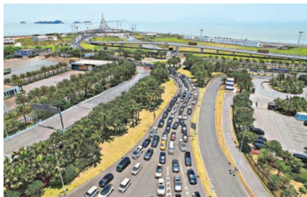
■大量出入境車輛駛經港珠澳大橋口岸。
