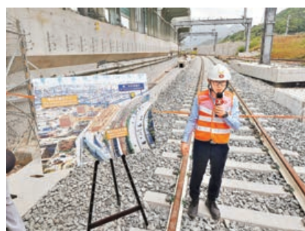
■港鐵項目主管指道岔安裝工序複雜。
