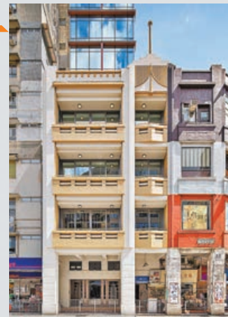
■ Hotel 1936 保留了唐樓面貌。
