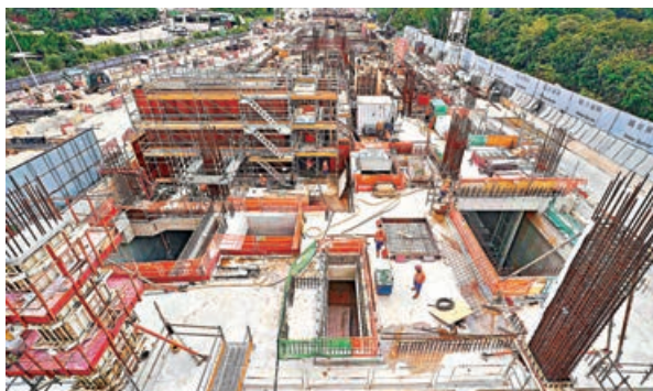
古洞站地面樓層板工程即將完工。港鐵提供
