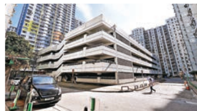
■圖片左邊的車輛停泊在安定邨辦事處管理的路段上，右邊由兆安苑停車場管理的路段則未見有車輛停泊。
